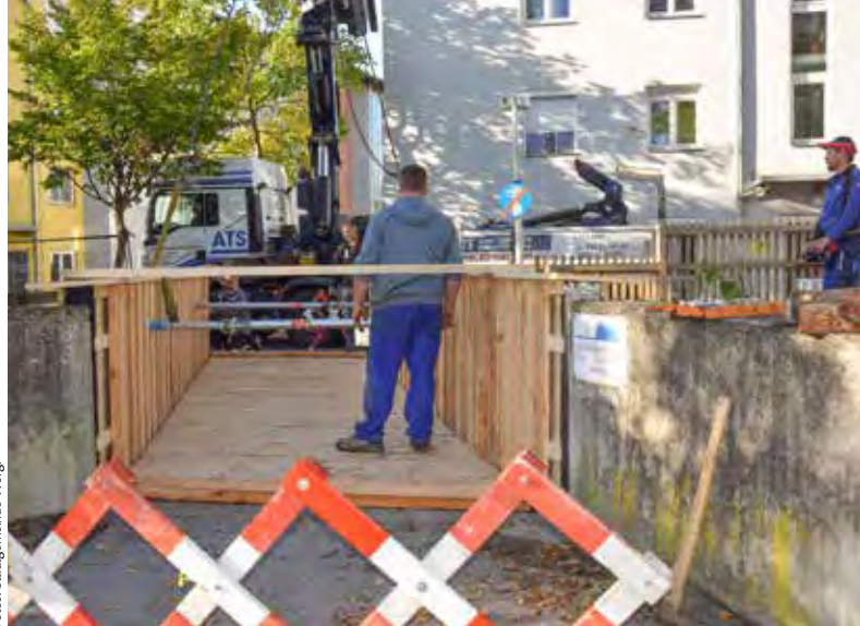
In einem Stück wurde die neue Brücke mittels Kran in die alte Position eingehoben.
