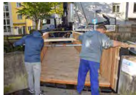
"Sitzt, passt, hält, wackelt und hat Luft." Die neue Brücke ist wieder begehbar und eine Erleichterung für die Anrainer auf der anderen Seite des Wörgler Baches.
