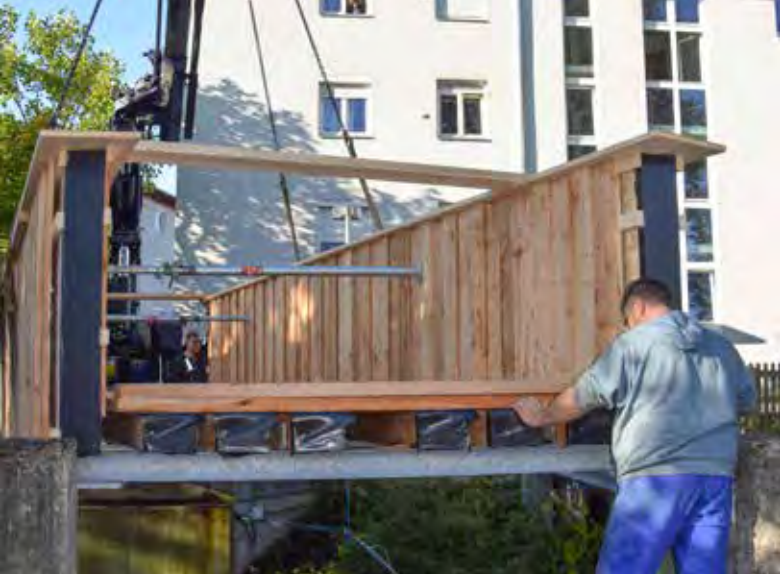
Auf den Millimeter genau wurde der neue Fußgängerübergang eingepasst.
